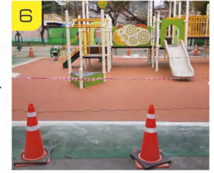
6 포설 및 다짐 Laying and compaction
