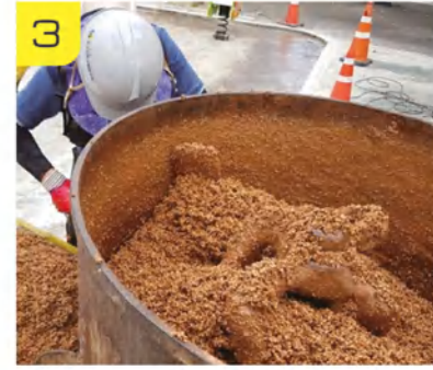
3 코팅 코르크 칩 - 바인더 교반 Coated cork chips-binder agitation
